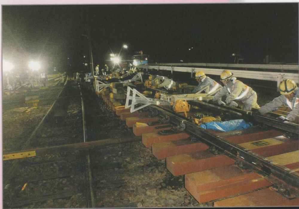
施設現場で働く鉄道マン (分岐器全更替)
